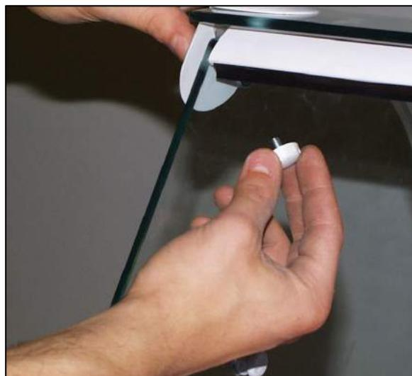
Inserire il profilo superiore come mostra la figura. Fissare gli angolari di serraggio vetri tramite le apposite viti in dotazione. Ogni angolare deve essere fissato tramite due viti, una sulla parte laterale e una sulla parte superiore. Quest'ultima ha il compito di serrare anche il profilo superiore.
