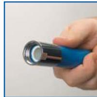
2: Die Hülse soll bis ca. 3/4 ihrer Länge im Uhrzeigersinn auf den Schlauch aufgedreht werden. Bei Schwergängigkeit kann ein Gabelschlüssel hilfreich sein.
